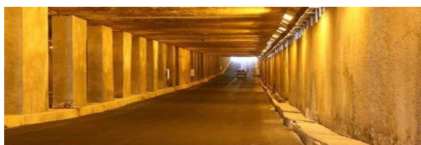
Fig. 1. Dakar / Senegal Soubédjioune tunnel.
