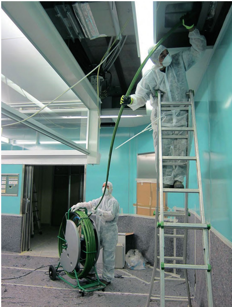
Fig. 3. Illustrative picture of professional activity of HVAC components inspection and cleaning from the publication “Impianti di climatizzazione: salute e sicurezza nelle attività di ispezione e bonifica” edited by Italian INAIL Institute [4]
